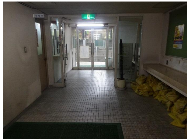
浸水の恐れのある地階通用口
