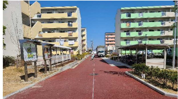
④建替え後の府営羽曳野古市住宅
