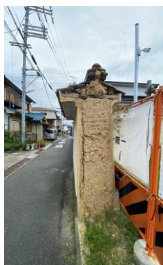
■敷地北側 土塀
