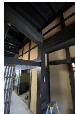
■主屋 内観 玄関土間
