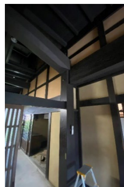
■主屋 内観 玄関土間
