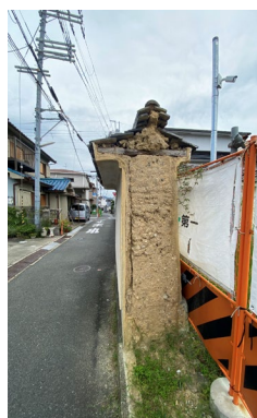
■敷地北側 土塀
