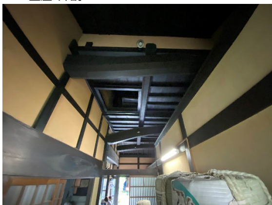
■主屋 内観 玄関土間
