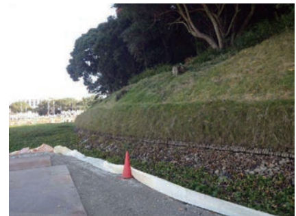
じゃかごと植生シートによる 浸食防止対策の例
