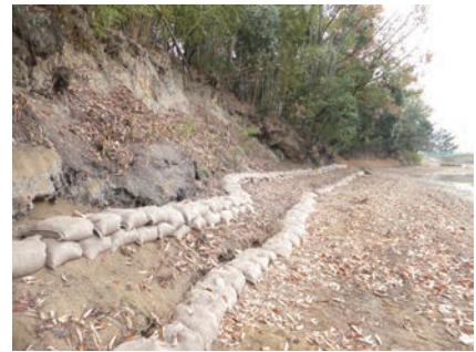
土砂流出防止のための仮設土のう
