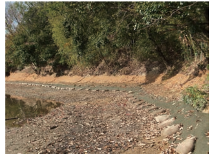
敷設した植生マット
