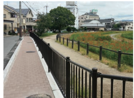
水路の遊歩道化を進めている外周路
