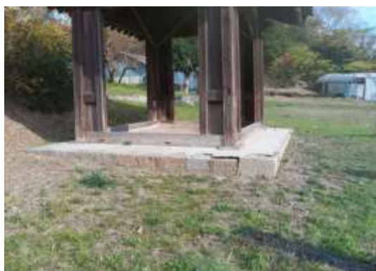
図56 鐘楼基壇埋没状況（境内エリア）
