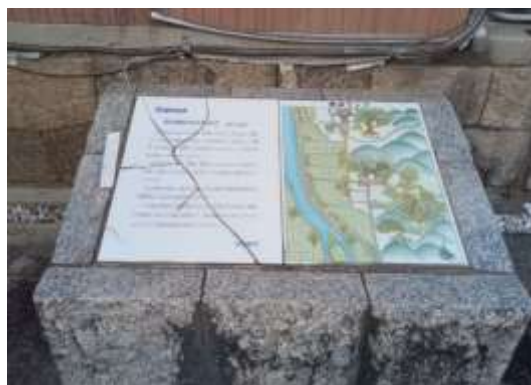
図55 山門前解説板(陶板)亀裂状況（境内エリア）
