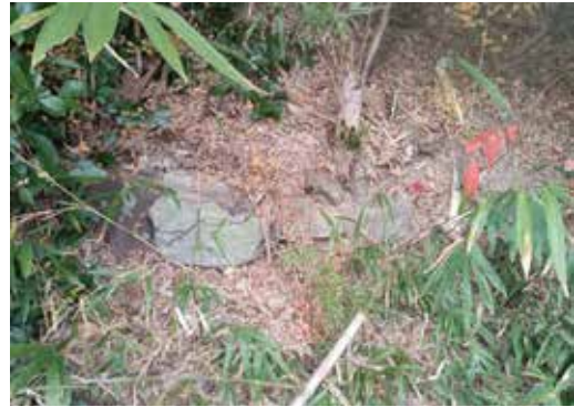
図57 境内地北側石垣露出地点 (境内エリア)
