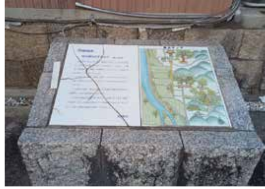
図55 山門前解説板(陶板)亀裂状況 (境内エリア)
