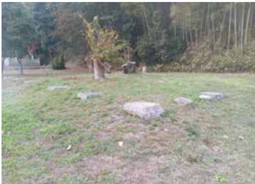
図58 本堂基壇礎石露出状況 (境内エリア)
