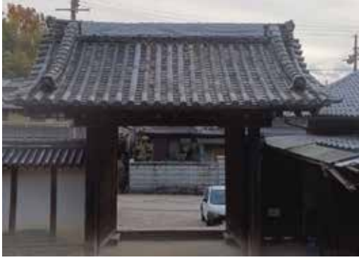
図54 山門大棟の応急処置状況 (境内エリア)
