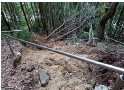
図64 崩落した義家墓へ向かう通路 (墓所周辺エリア)
