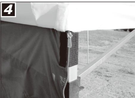
4 一方幕の場合は この時点で天幕を戻し天幕のマジックテープと横幕、フレーム柱部のマジックテープとをしっかりと貼り付けて完成です。
