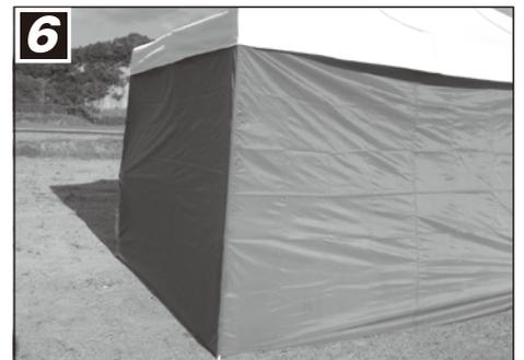
6 すべての横幕を連結した後、天幕を戻し天幕のマジックテープと横幕、(フレーム柱部)のマジックテープとをしっかりと貼り付けて完成です。
