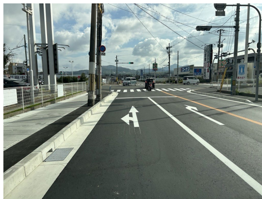
道路の整備・改善(西浦交差点)
