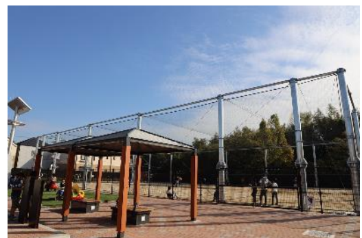
公園施設の充実(島泉まちかどあそび広場)
