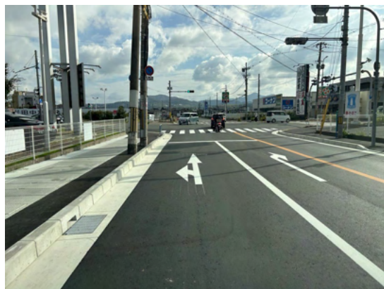
道路の整備・改善(西浦交差点)
