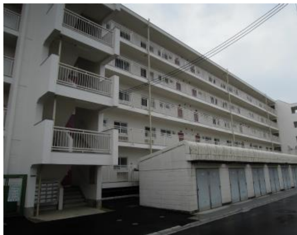
耐震・改善工事後の市営住宅
