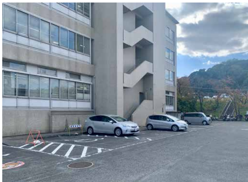
⑯ 庁舎棟北側と法面
