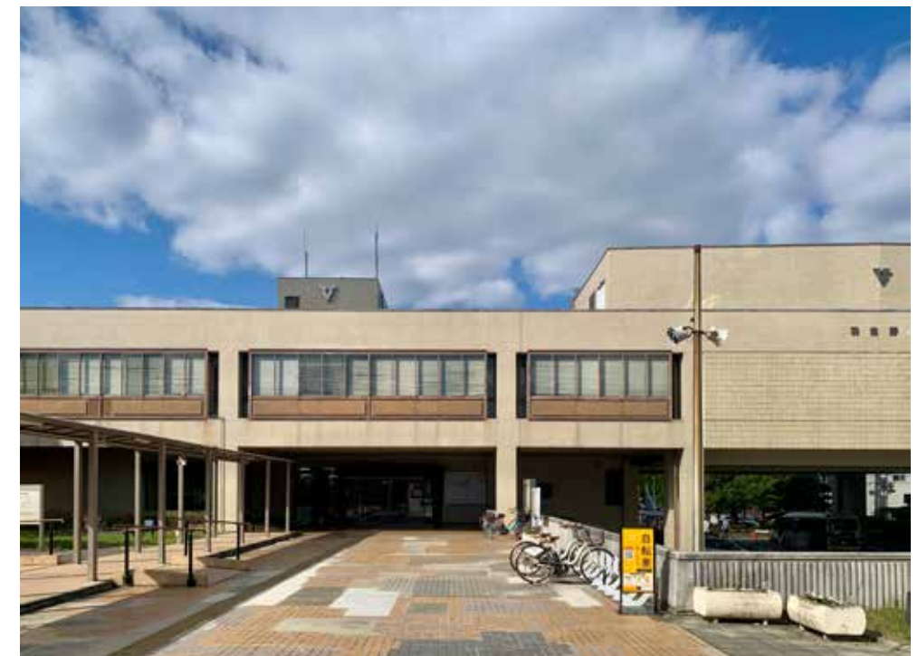
③庁舎棟南側入口付近
