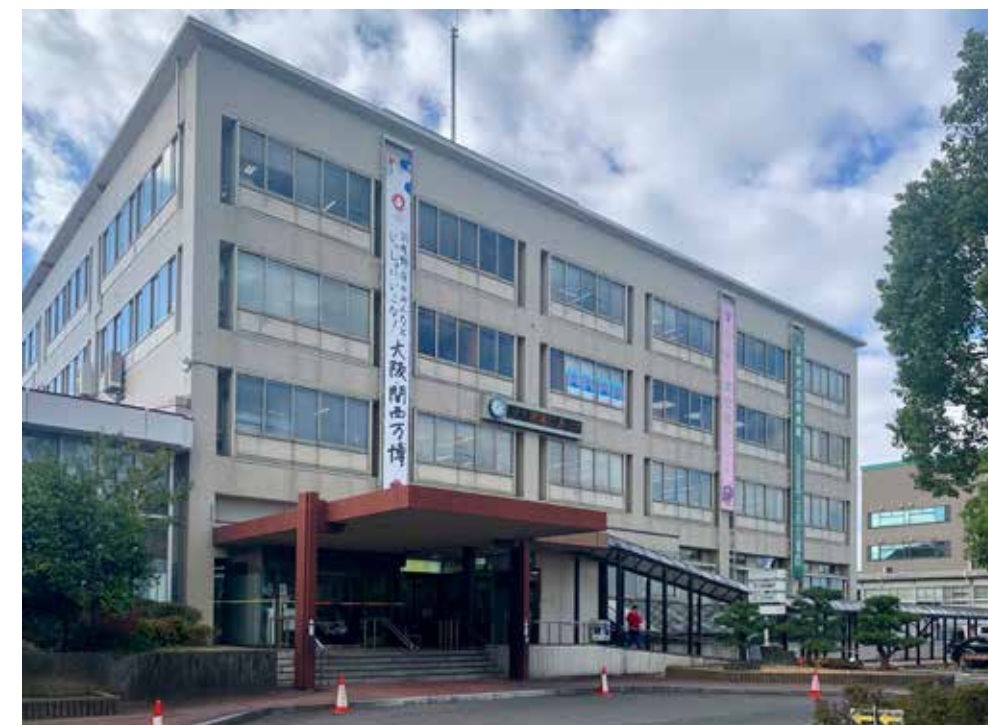
⑨庁舎棟正面側全景
