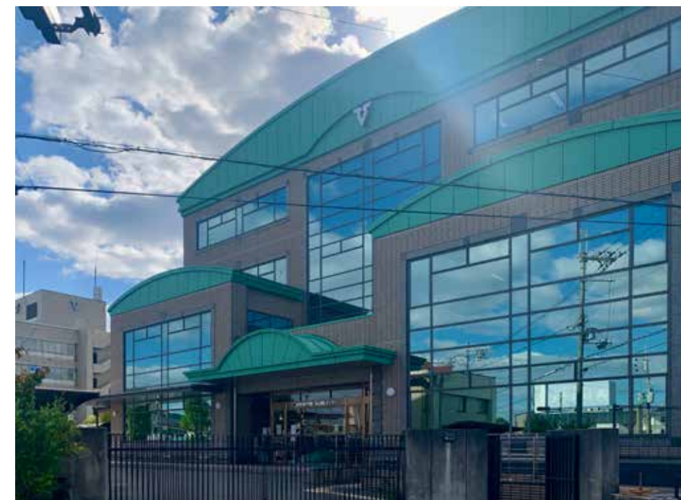
⑮ 別館正面側全景
