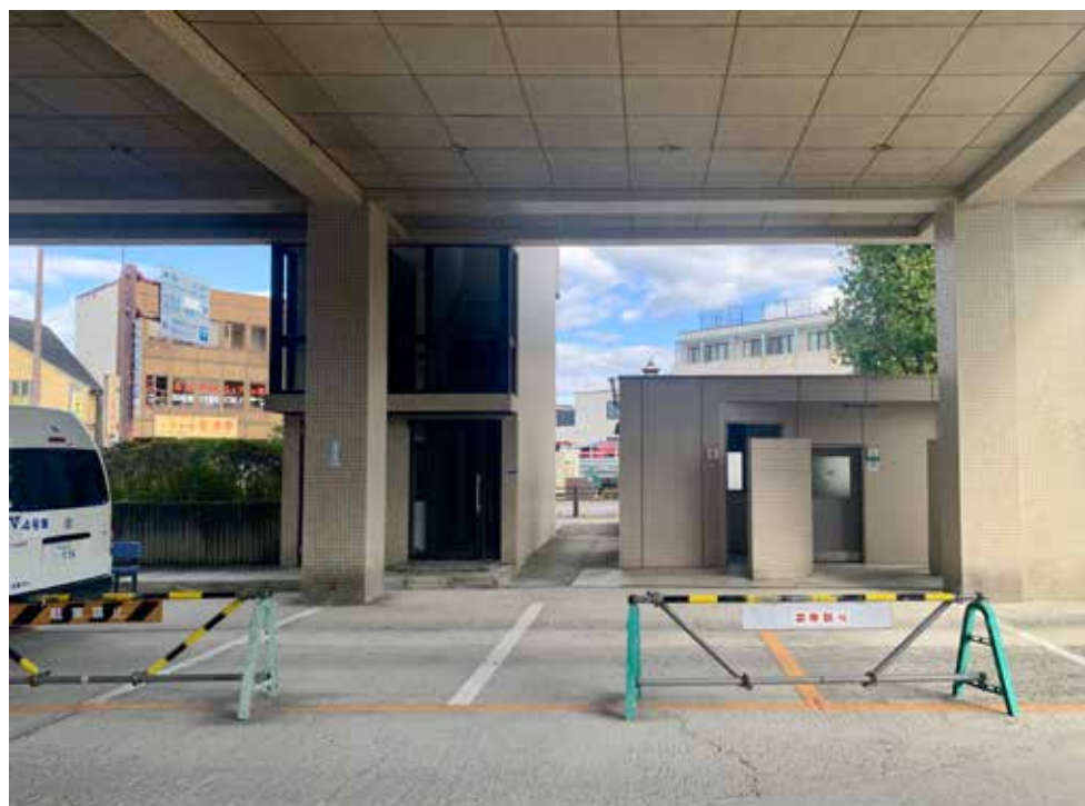
⑧庁舎棟ピロティと外部トイレ
