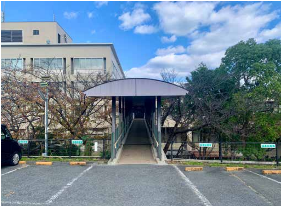
②⑤ 渡り廊下・屋根 3
