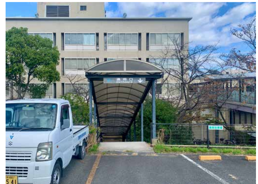
㉔庁舎棟法面階段・屋根
