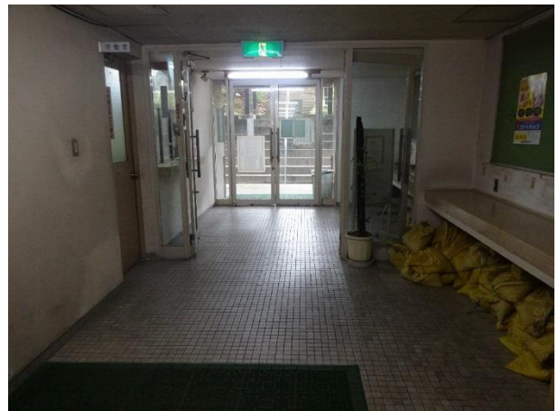
浸水の恐れのある地階通用口
