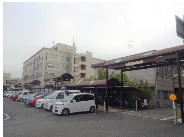
本館から別館への通路
