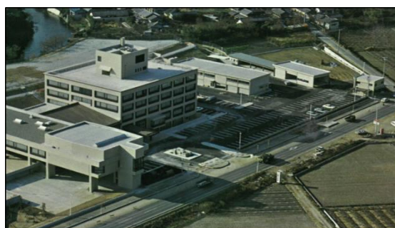
建設当時の本庁舎
