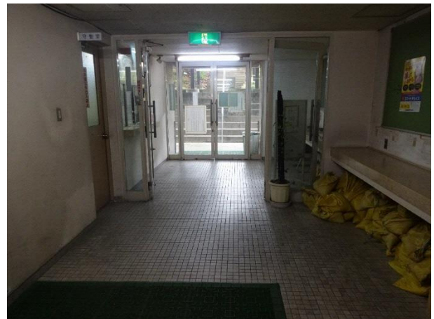
浸水の恐れのある地階通用口
