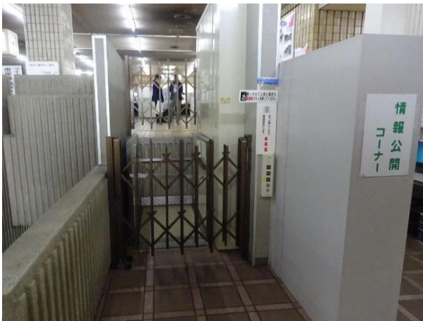
東玄関の段差解消機
