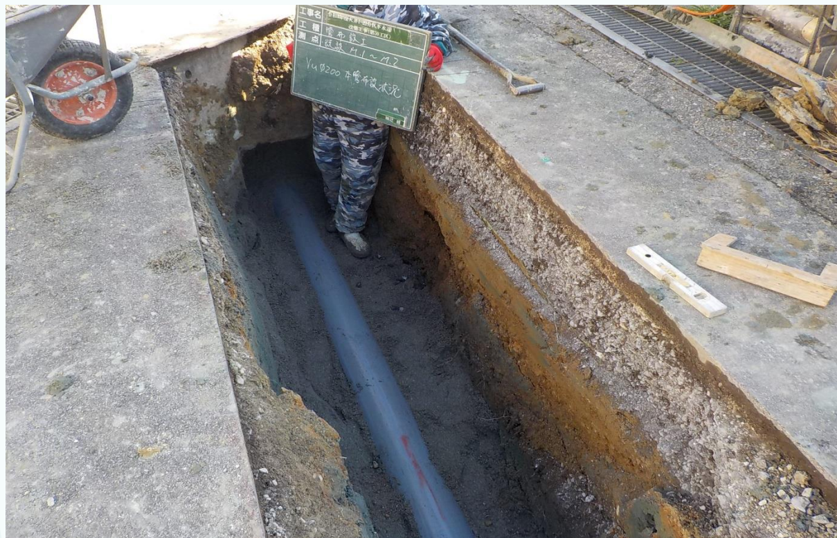
管渠更新工事
