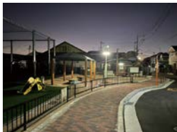
<照明灯(災害時は電源が取れる)>
