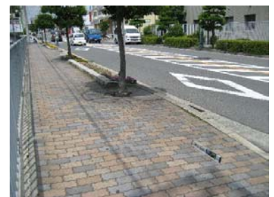
市道郡戸古市線 歩道
