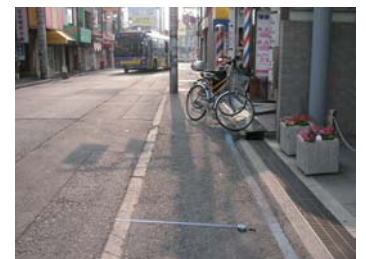
国道166号南側歩道
