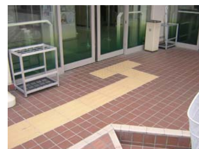
（例）視覚障害者誘導用ブロック
