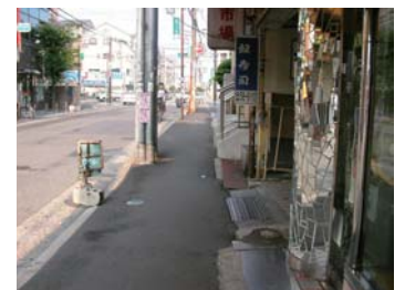
国道166号北側歩道
