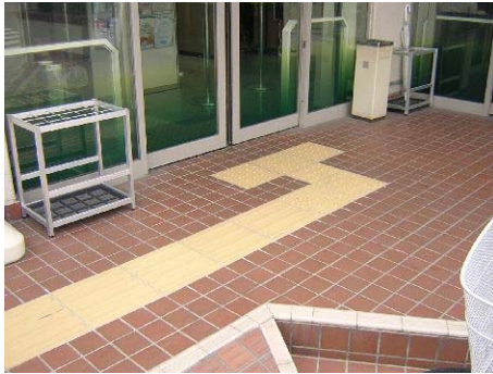
(例) 視覚障害者誘導用ブロック
