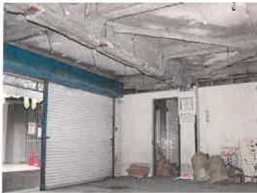
吹付けアスベスト等が飛散し、暴露する可能性が高い
