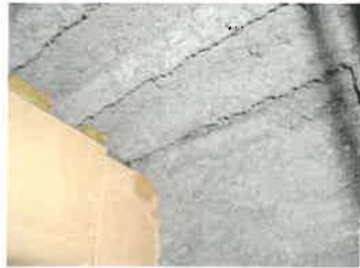
吹付けアスベスト等が飛散し、暴露する可能性が高い
