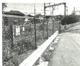
フェンスの改修
