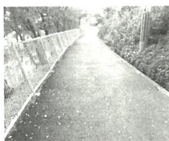
通学路の改修
