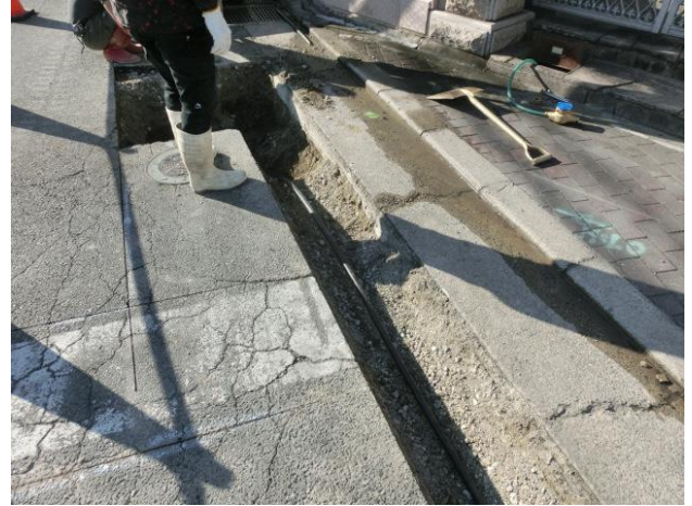
仮設管連絡給水替え
