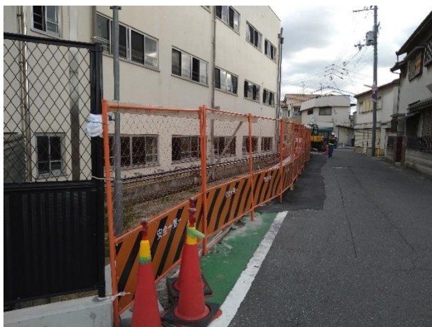
現場全景（起点側から）
