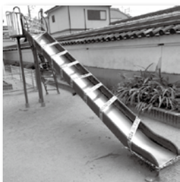
遊具の使用禁止措置状況
