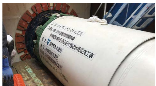
▲伊賀受水場の送水管の更新・耐震化工事
