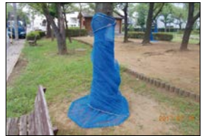
防虫ネット施工例
