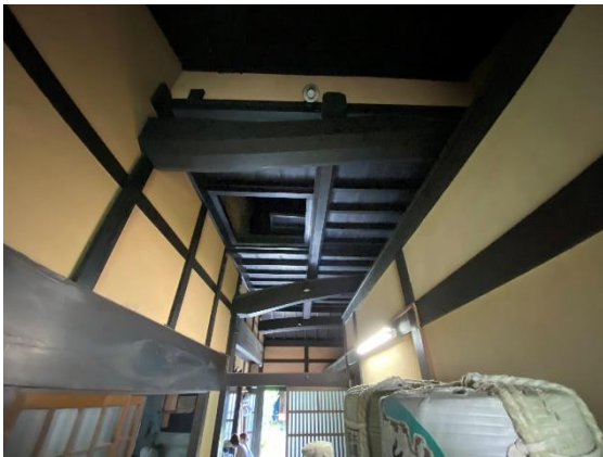
■主屋 内観 玄関土間
