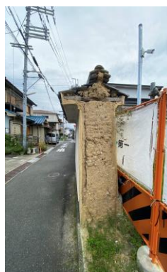
■敷地北側土塀
