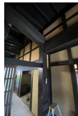
■主屋 内観 玄関土間
