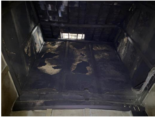
■主屋内観 土間上部
